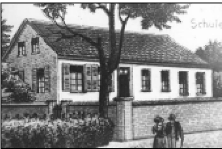
Die älteste evangelische Schule in Walsum an der Provinzialstraße (heute Friedrich-Ebert-Straße), erbaut 1832, abgebrochen 1941.
